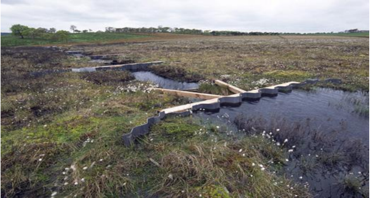
სურ.10 გუმბათოვანი ჭაობის ჰიდროლოგიური რეჟიმის აღდგენა სადრენაჟო არხების გადატიხვრის მეთოდით. ბლოუპორნის ალკვეთილი, ცენტრალური შოტლანდია
